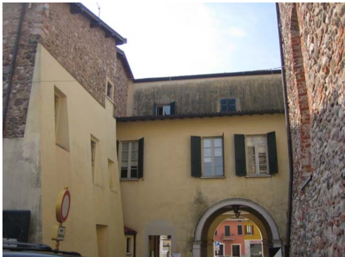
Vista retro edificio lato nord-ovest e passaggio carraio
