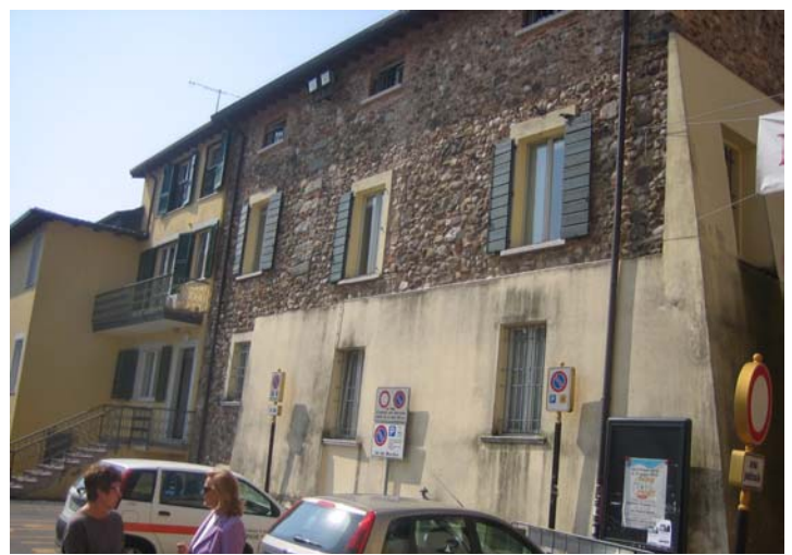
Vista retro edificio lato nord
