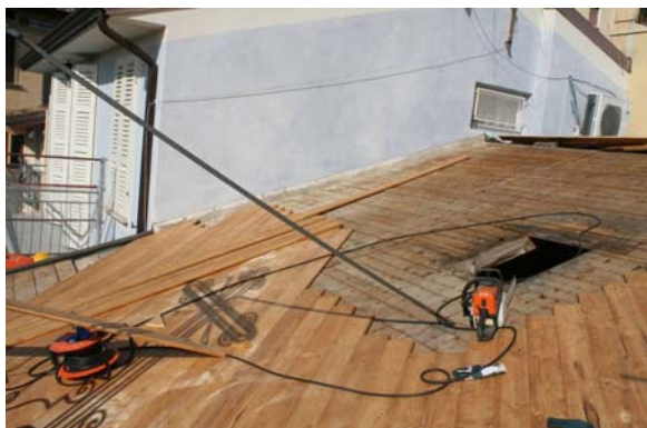
Esempio di posa del secondo assito incrociato
