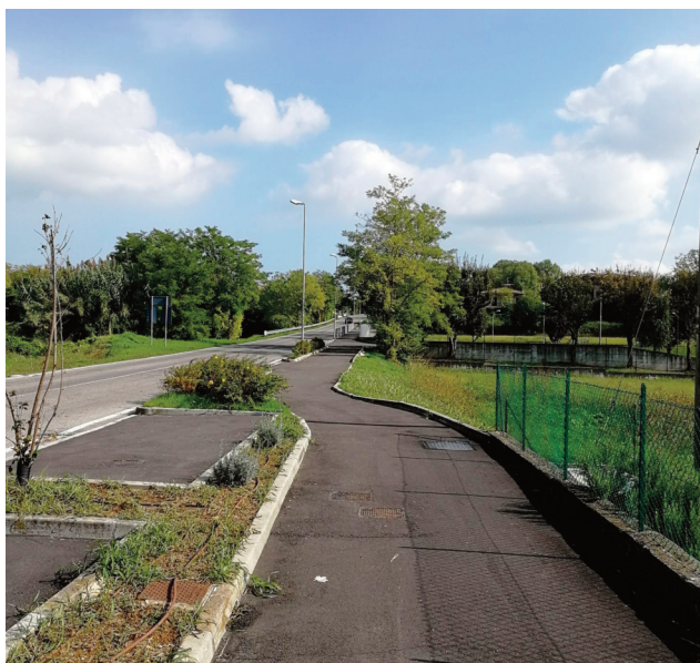
Asfaltatura marciapiede tra San Vito e Campagnola
